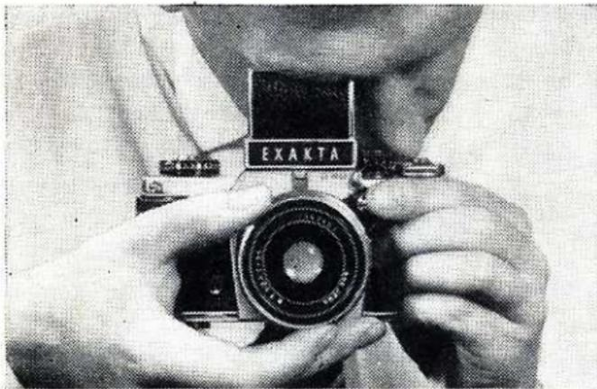
2. Scharfeinstellen durch Drehen am Entfernungseinstellring (25) und durch Kontrollieren der Schärfe des Reflexbildes.
