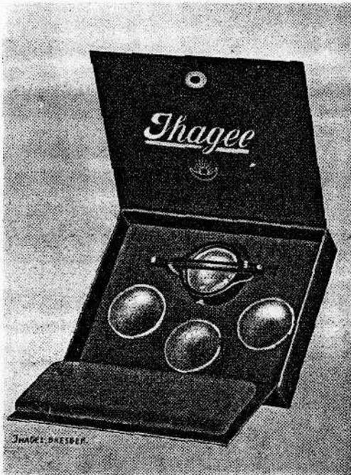
Der Ihagee=Satz macht jede Kamera zu einem Universalinstrument. Er besteht aus dem Vorsatzlinsenhalter, der durch Zusammendrücken zweier Federn auf die Sonnenblende des Objektivs gesetzt wird, und 4 Vorsatzlinsen:
